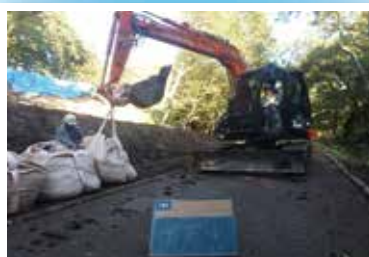
コンテナバック設置
