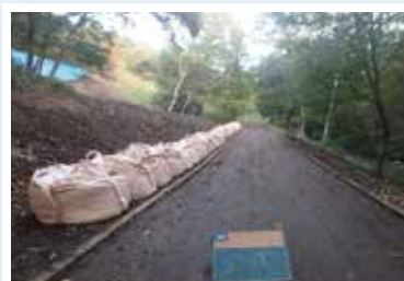
コンテナバック設置
