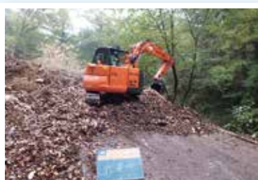
土砂撤去作業
