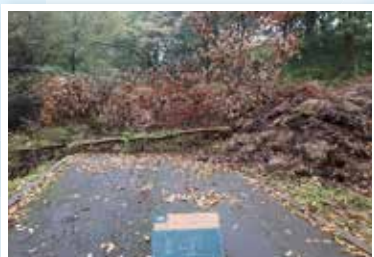
土砂崩落による倒木
